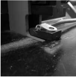
4. Colocación correcta del conector de bandera de cordón de soldadura de bronce en régimen inferior.
